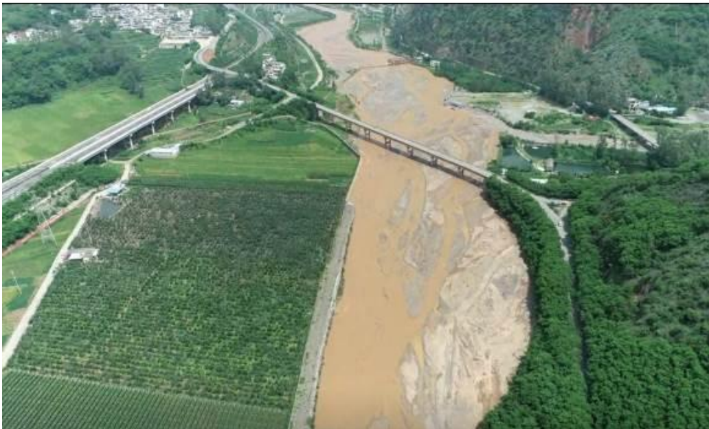
K9+450~K9+850 段河岸现状及堤线布置
