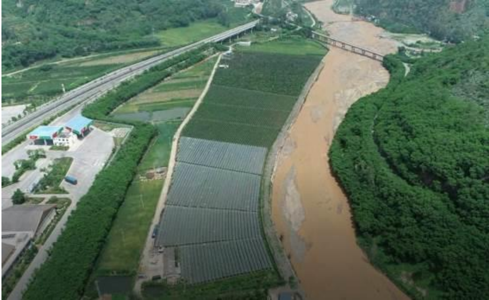
K8+450~K9+250 段河岸现状及堤线布置
