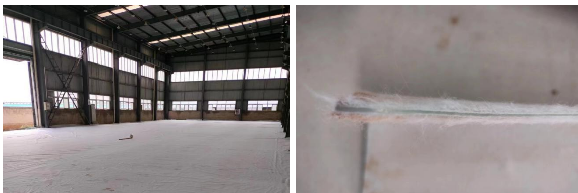
图 4.2.5-1 生产车间铺设防渗复合土工膜施工现场照片
