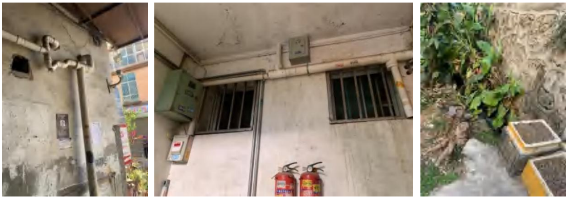
部分居住小区楼道内污水排水管及生活污水渗漏情况照片
