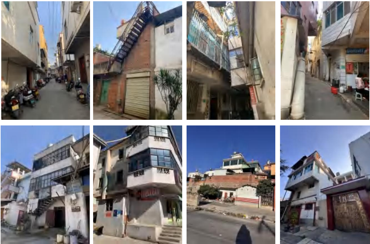
部分需整改自建房照片
