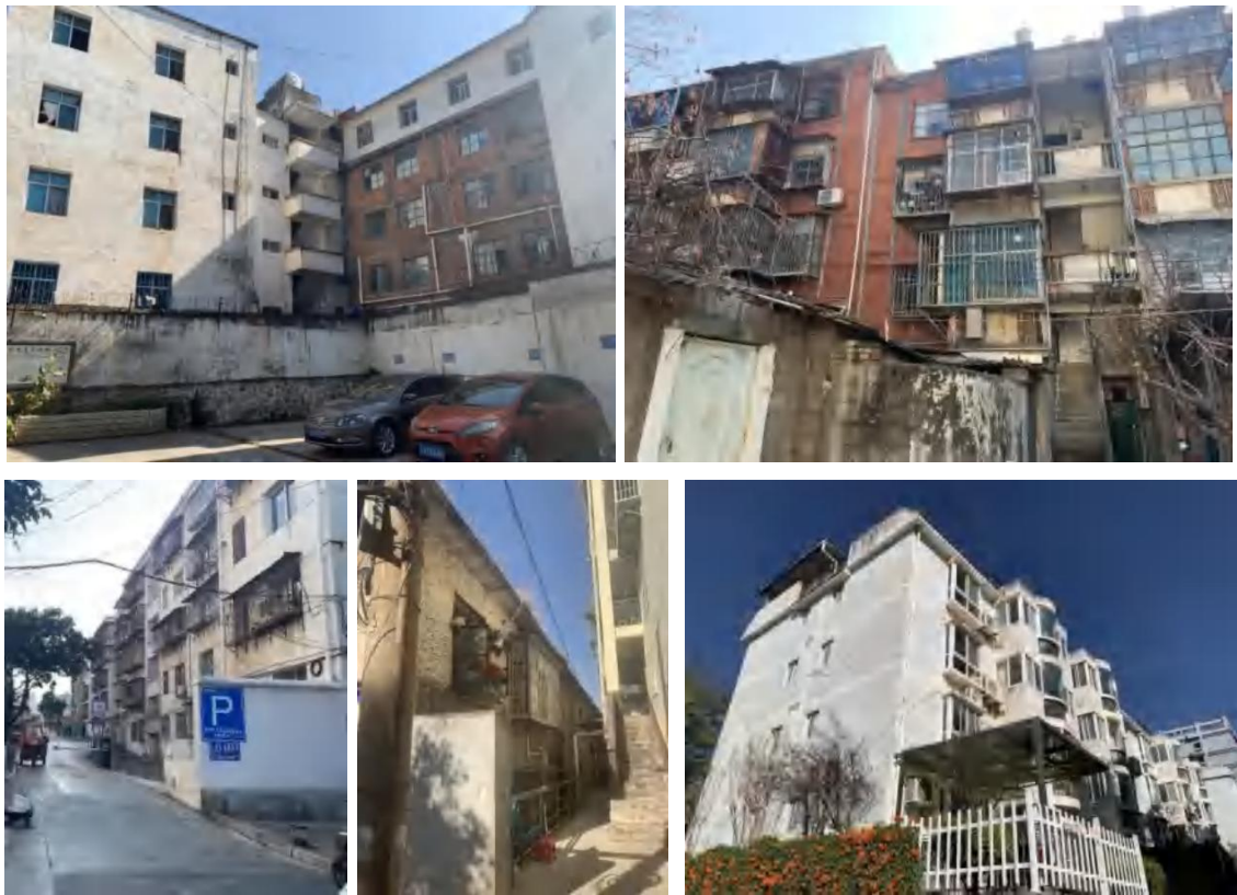
部分需整改老旧小区照片
