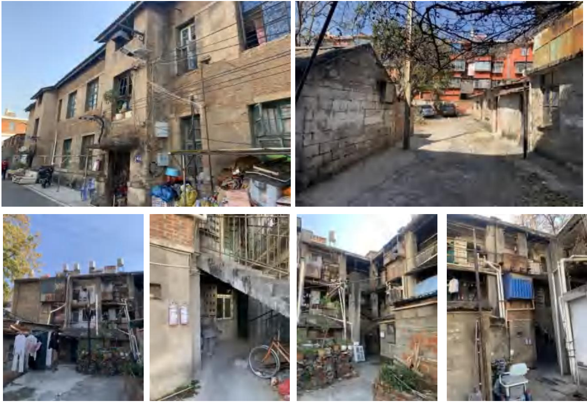
部分需整改C、D级危旧房照片
