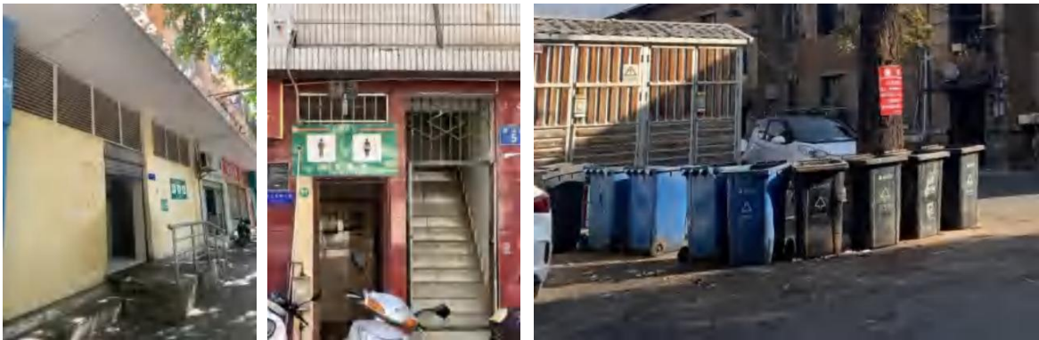
公厕、垃圾收集现状照片
