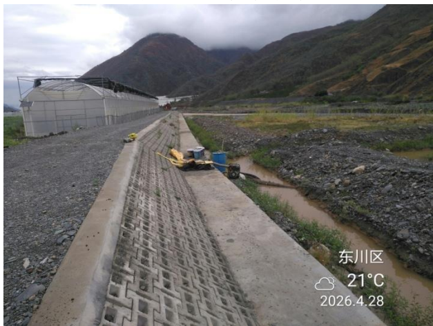
下游段已完成工程现状
