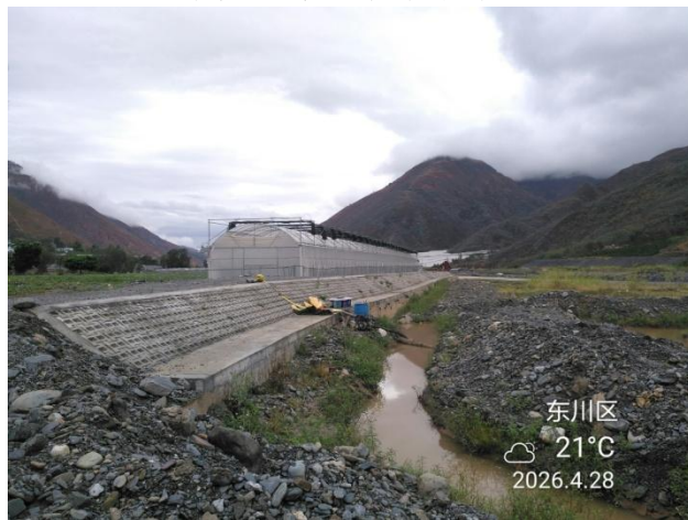
下游段已完成联锁式堤坝
