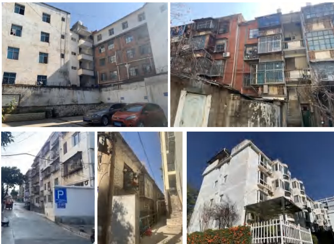
部分需整改老旧小区照片
