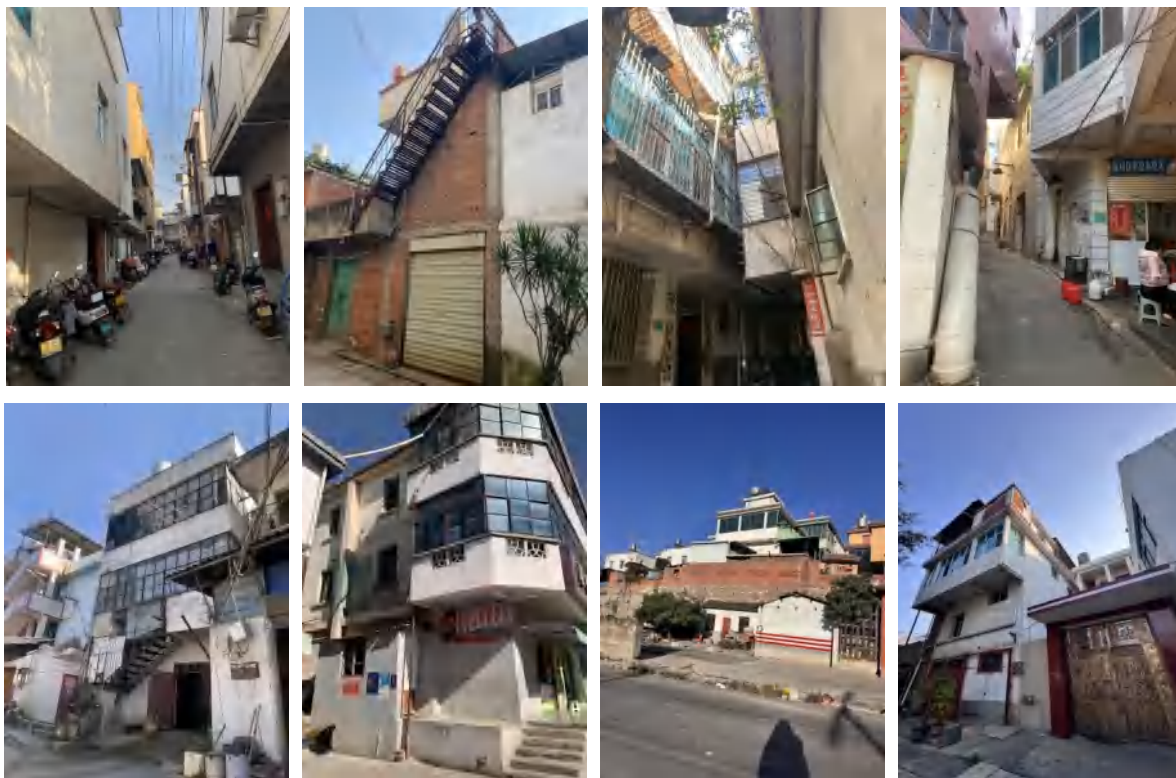
部分需整改自建房照片
