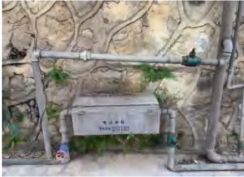
部分老旧给水管照片
