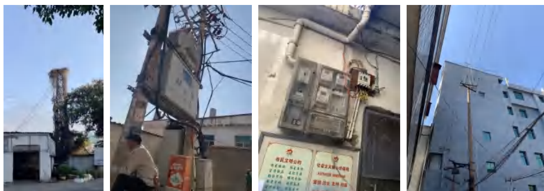
部分电力设施老旧照片
