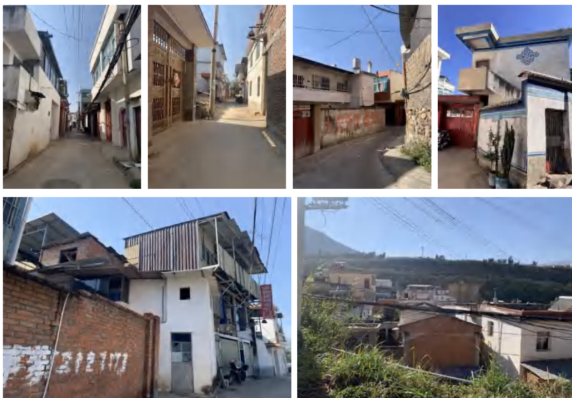
部分需整改城中村照片
