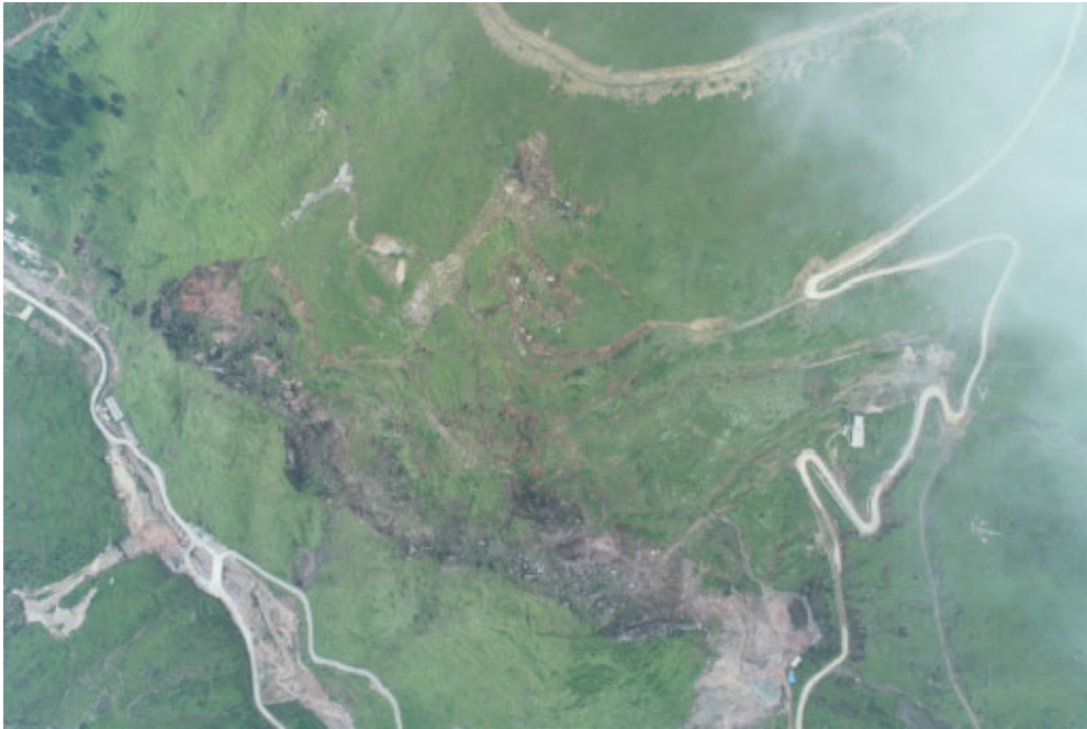
照片 2.4-2 因民镇舍块乡云坪村西旱坡地面塌陷
