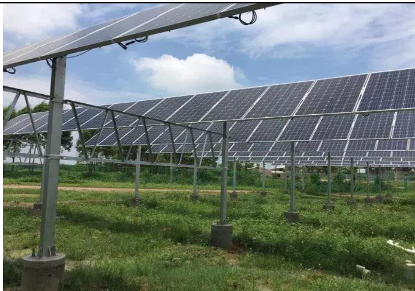
图 2-3 固定式安装运行方式
