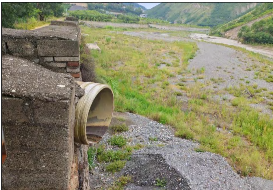
图 2.1-3 项目尾水入小江排放口现状
