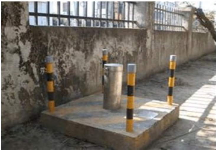
图 7.2-1 地下水监测井式样
