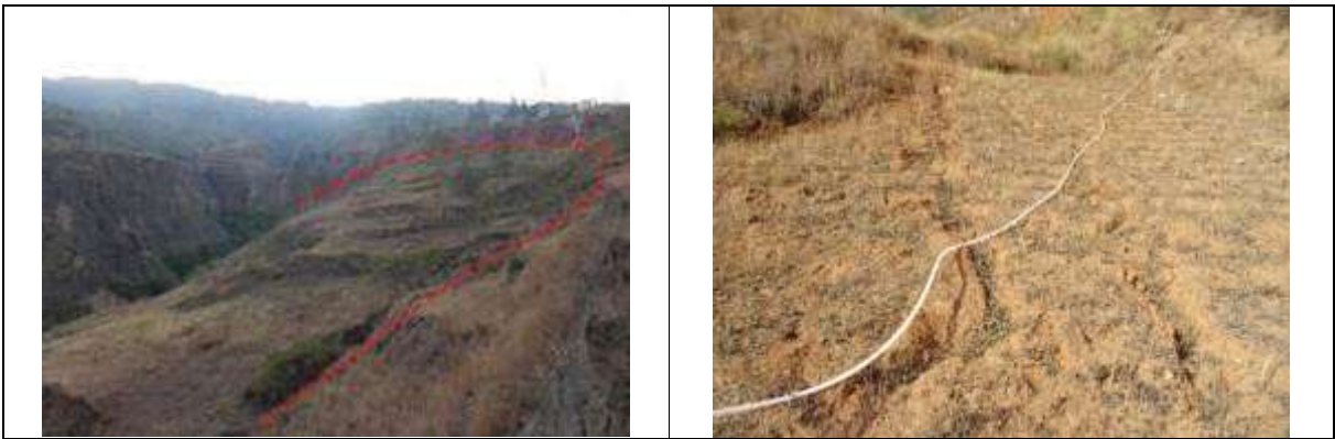
图 4.1-2 刺棵田滑坡现状
